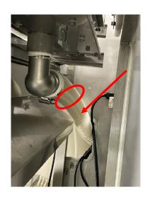
②の赤丸部の亀裂部写真。写真のホースダクトは版 投入口から見て左側だが、右側は見えないので交換 する事も一案。
